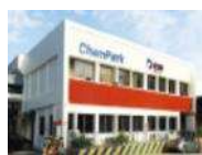
1 Third / 4 Fourh Lok Yang Rd
